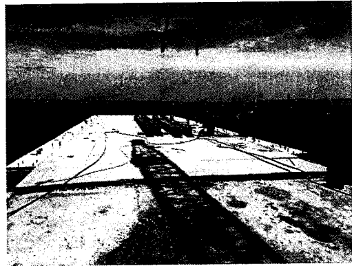
Fotografía N°10: trabajos en ampliación de cabezo.
